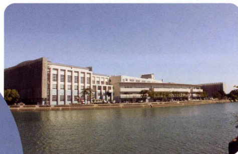
校舎全景(南より撮影)
